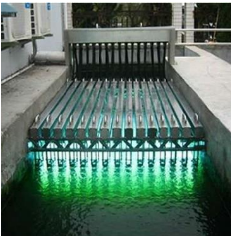
SLIKA 3-13 UV SISTEM KANALSKOG TIPRA
